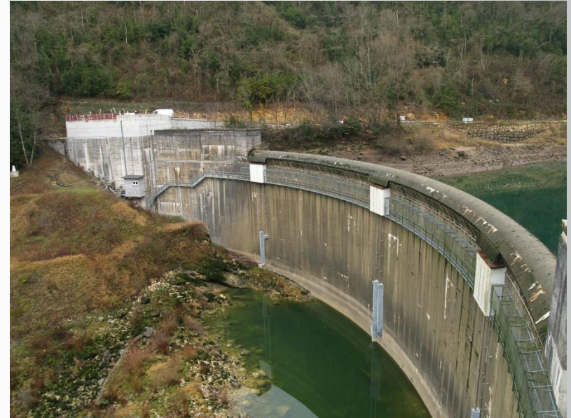
Barrage EDF de Choranche, Isère (38) , France 16 tirants d'ancrage 22T15 type P2 - instrumentés
