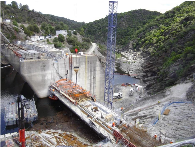
Barrage EDF de Malarce Ardèche (07) , France 12 tirants d'ancrage 12T15 type P2 - instrumentés
