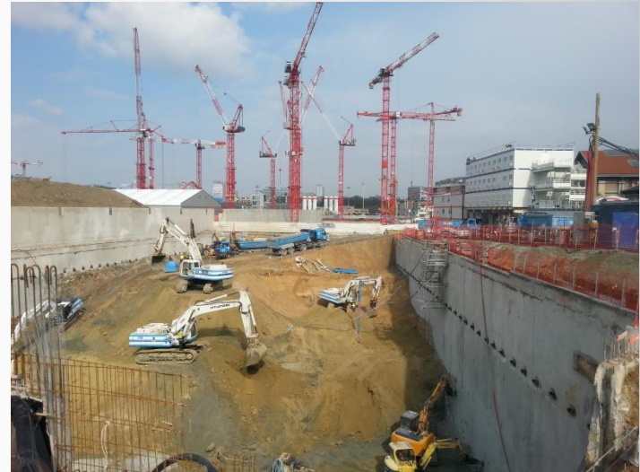
Paroi Moulée – projet DRPJ, Paris , France 252 tirants d’ancrage 7 et 9T15 type P1
