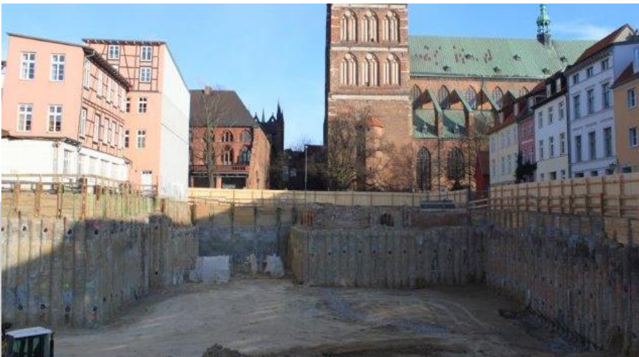
Paroi parisienne – Stralsund, Allemagne Centre ville médiéval classé au Patrimoine culturel de l’Unesco 320 tirants d’ancrage 4T15 temporaires
