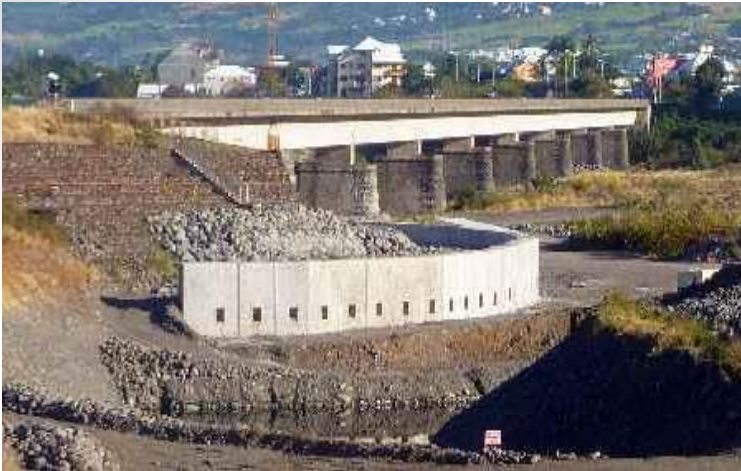
Paroi Moulée – Pont De La Rivière Saint Etienne, La Réunion 108 tirants d’ancrage 12T15 type P2
